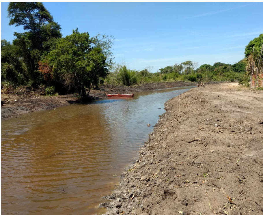
Limpeza do Rio das Moças, no bairro Jardim Ipitangas: prevenção contra enchentes
