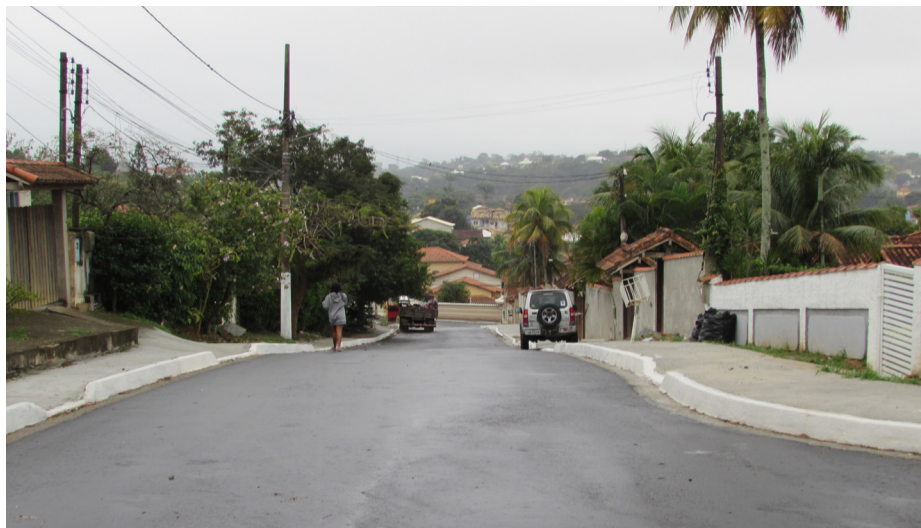
Diversas ruas da Raia e do Porto da Roça receberam as obras de drenagem e pavimentação
