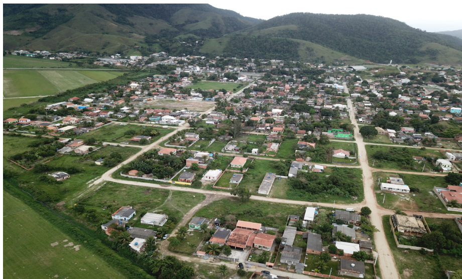
Nesta etapa, está prevista a pavimentação de 13 ruas da Basiléa, em um total de 5km de vias
