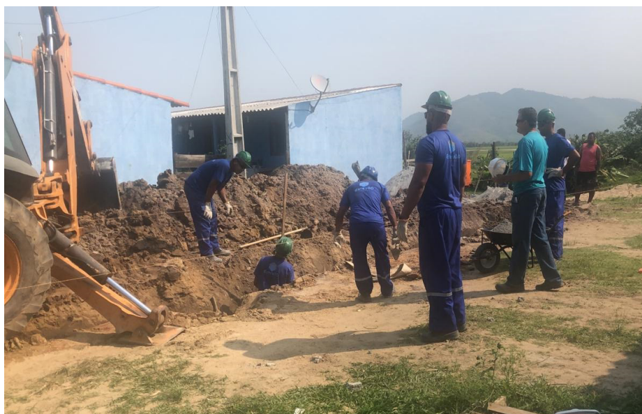
Máquinas, equipamentos, material e profissionais já estão no bairro. As obras já foram iniciadas
