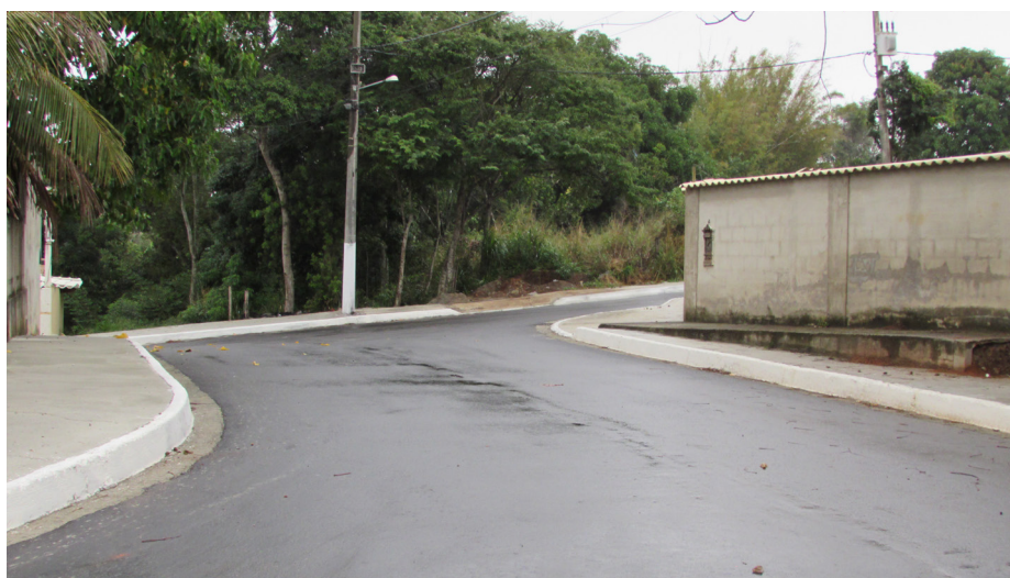
Como na Raia, Basiléa e Barra Nova, ruas do Asfalto Velho serão drenadas e pavimentadas
