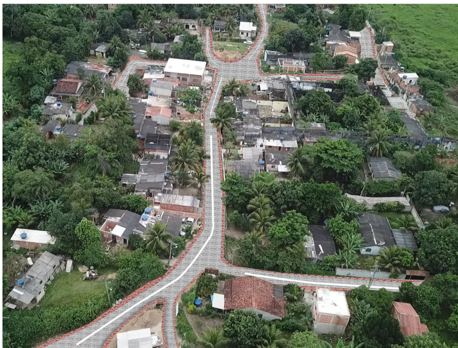
Projeto para o Charqueado contemplará calçamento das ruas, drenagem, nova praça e iluminação
