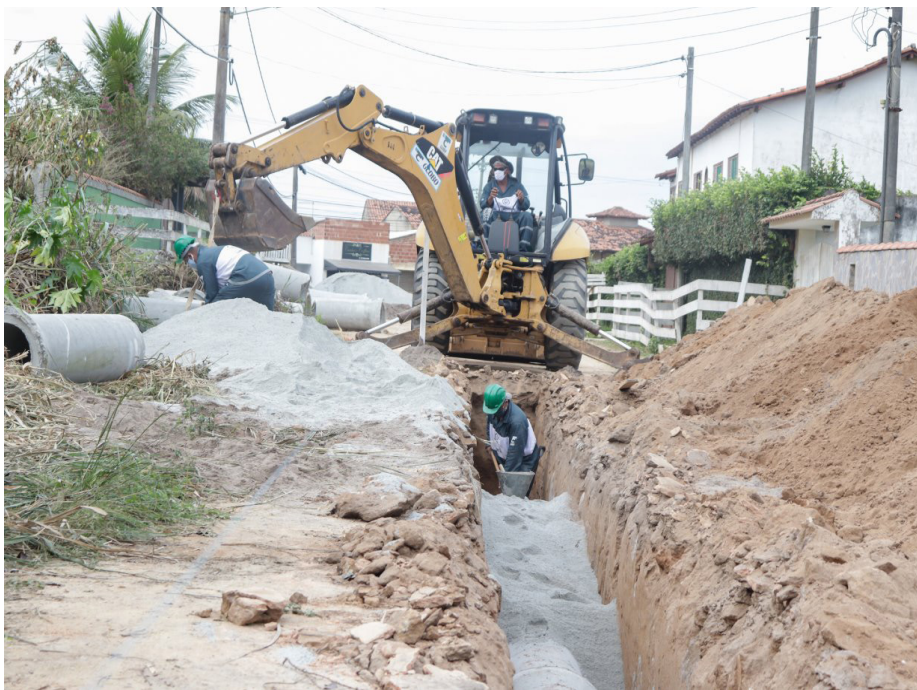
Obras em Vilatur totalizam mais de 9 quilômetros de vias drenadas e pavimentadas
