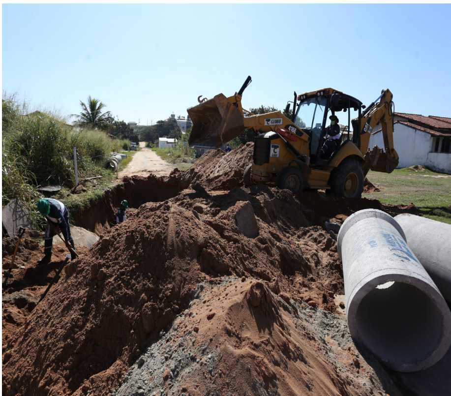
Obras já começaram e estão na fase de drenagem. Após, será feita a pavimentação
