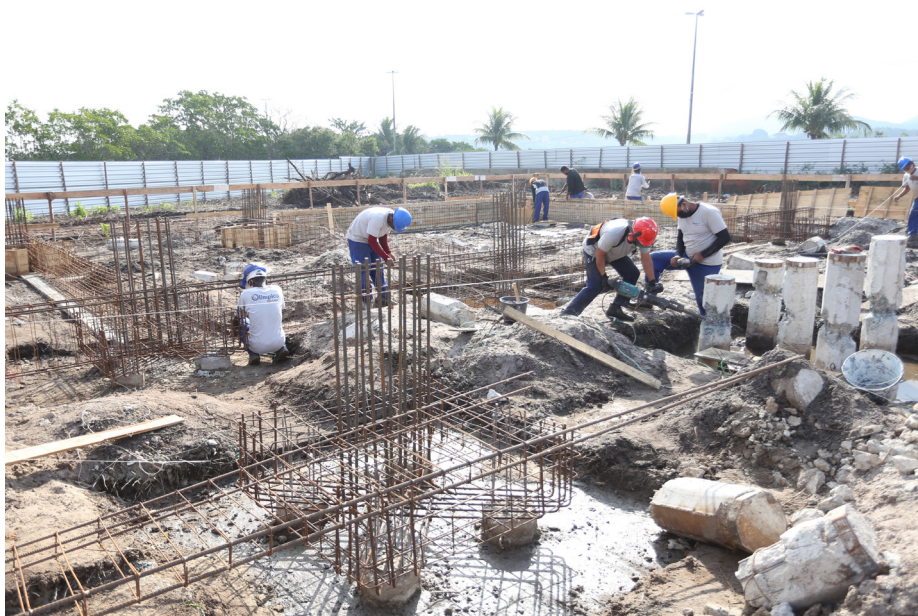
Após término da obra, nova escola Gustavo Campos terá quase 7 mil m 2 de área
