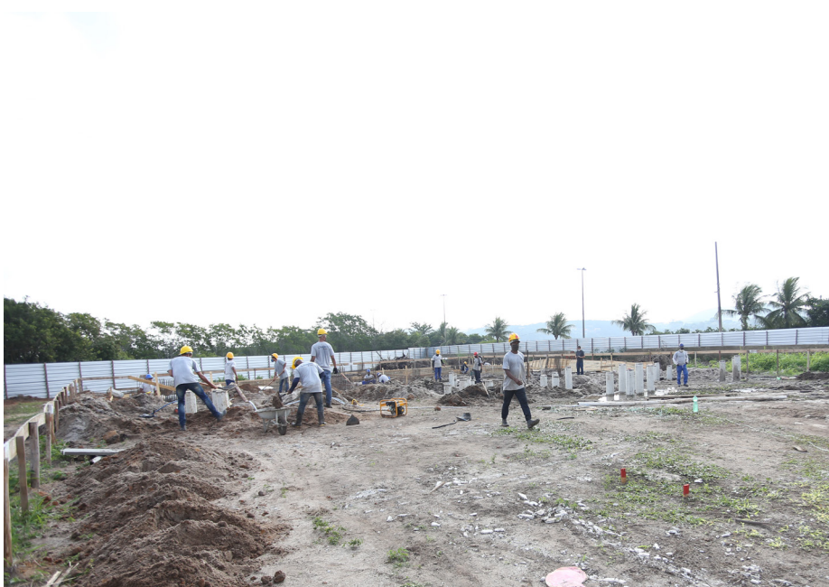
Obras estão na fase de fundação. Nova escola será uma das maiores do município
