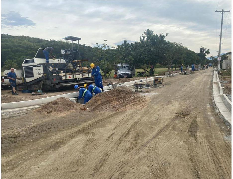
*Após a conclusão da drenagem, inicia-se a preparação do solo para pavimentação*
