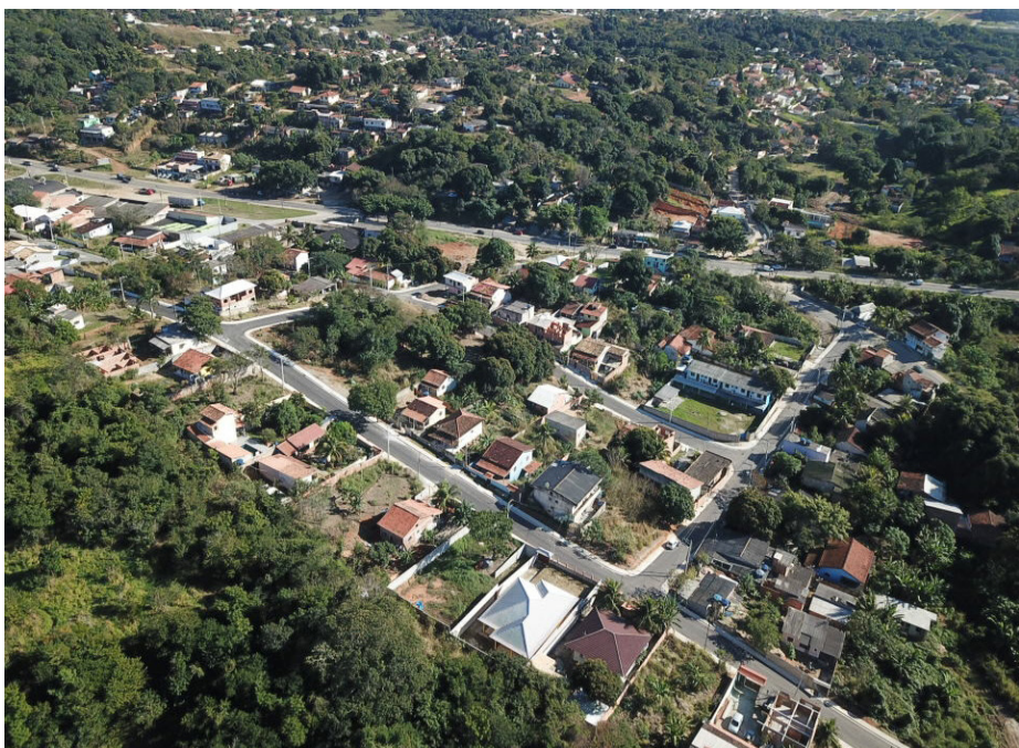
Ruas do Asfalto Velho receberam obras de drenagem, pavimentação e urbanização
