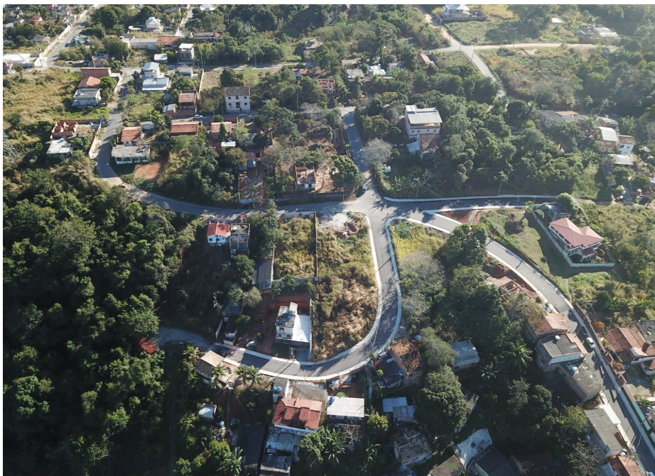
O bairro Recanto do Luar recebeu obras de drenagem, pavimentação e iluminação
