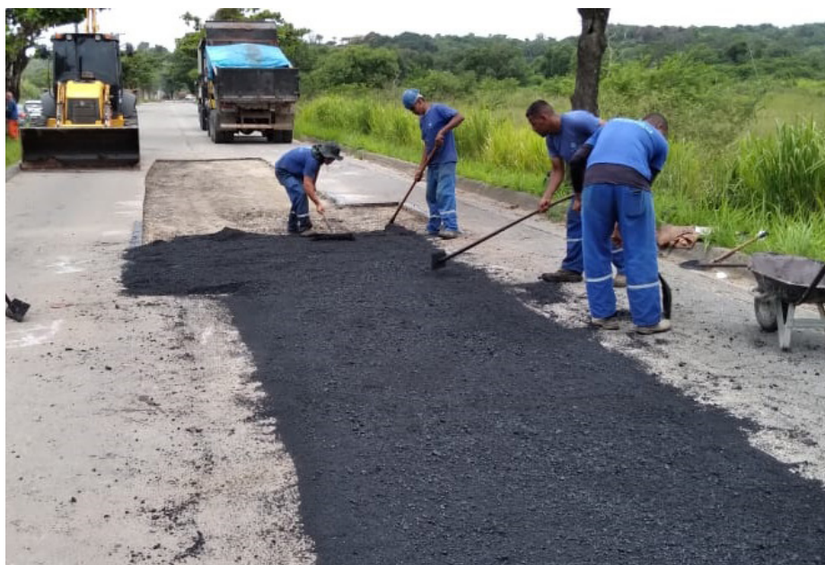
Avenida Nova Saquarema, em Vilatur, receberá serviços de reparo nos próximos dias
