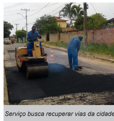
Equipes também estão trabalhando no bairro da Raia, fazendo reparo em diversas ruas
