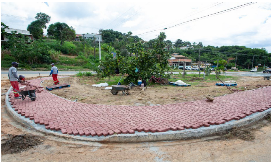
Nova praça está sendo construída pela Prefeitura no bairro Condado de Bacaxá
