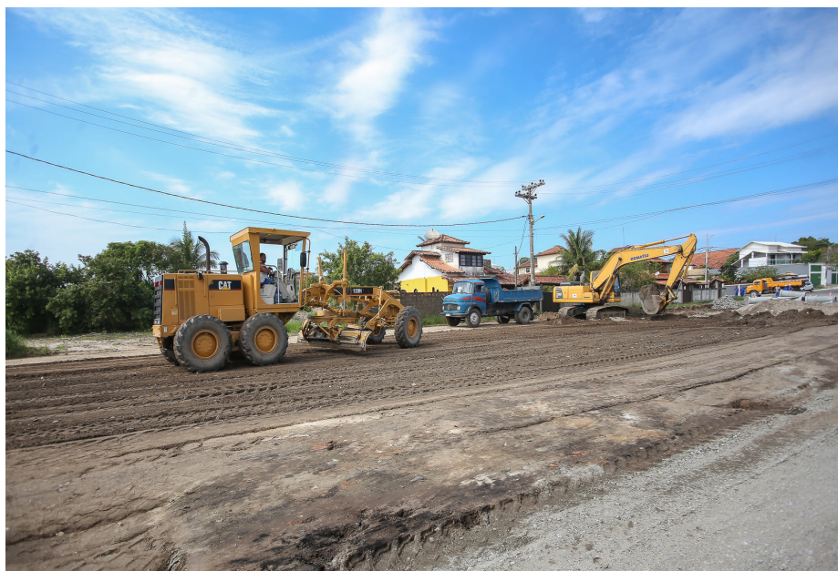
Pavimentação do bairro da Turfa contempla dois quilômetros de drenagem e asfalto
