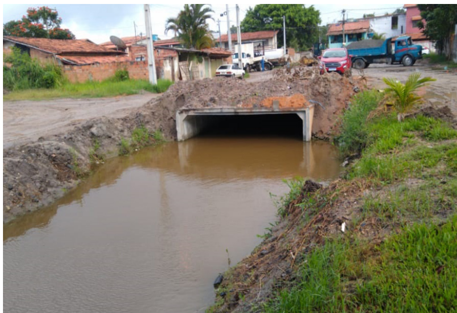
Uma galeria com 270 metros de comprimento foi construída para realizar a drenagem
