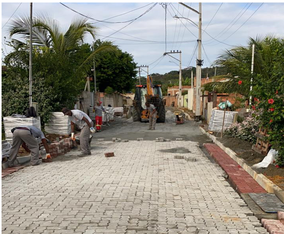
Pavimentação é executada com blocos intertravados: menor impacto ambiental na via
