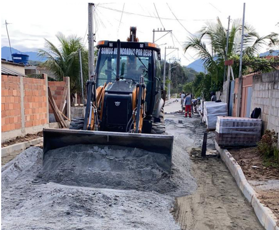
Obras contemplam drenagem, pavimentação e urbanização de diversas ruas do bairro
