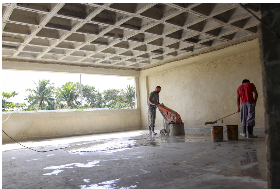
Obras da nova escola Gustavo Campos da Silveira: maior colégio da rede municipal
