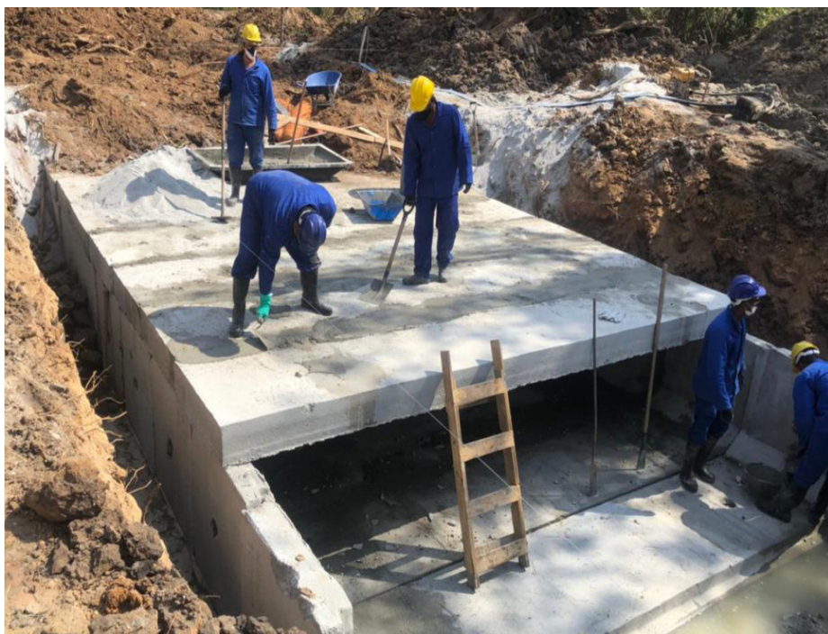
Galerias estão sendo construídas na Turfa e Porto da Roça para eliminar alagamentos
