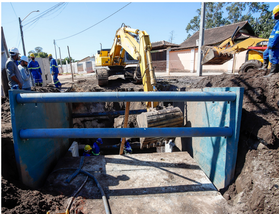
Obras do Programa Saquarema Não Para, da Secretaria de Desenvolvimento Econômico
