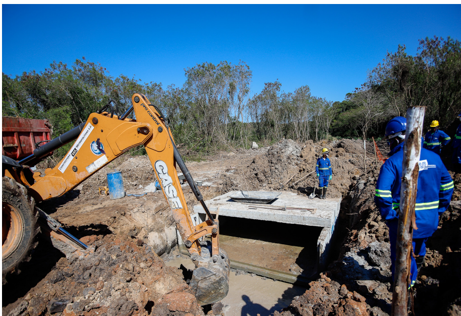
As obras de drenagem estão sendo realizadas na Turfa, Verde Vale e no São Geraldo
