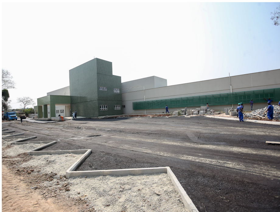
Rua na frente do novo Hospital Municipal Nossa Senhora de Nazareth já foi asfaltada
