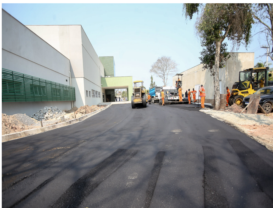
Pavimentação faz parte das obras de drenagem e urbanização de toda a Cidade da Saúde
