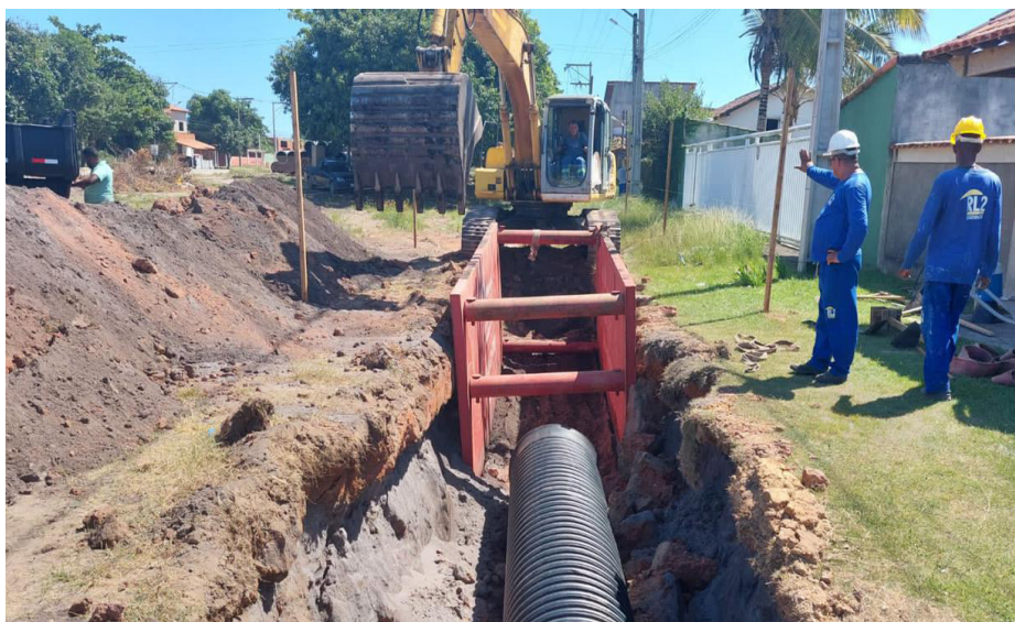
Obras da Nova Orla da Avenida Litorânea já estão em andamento com a drenagem do local
