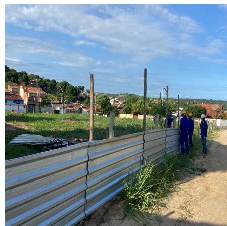
Fechamento do terreno para início da obra
