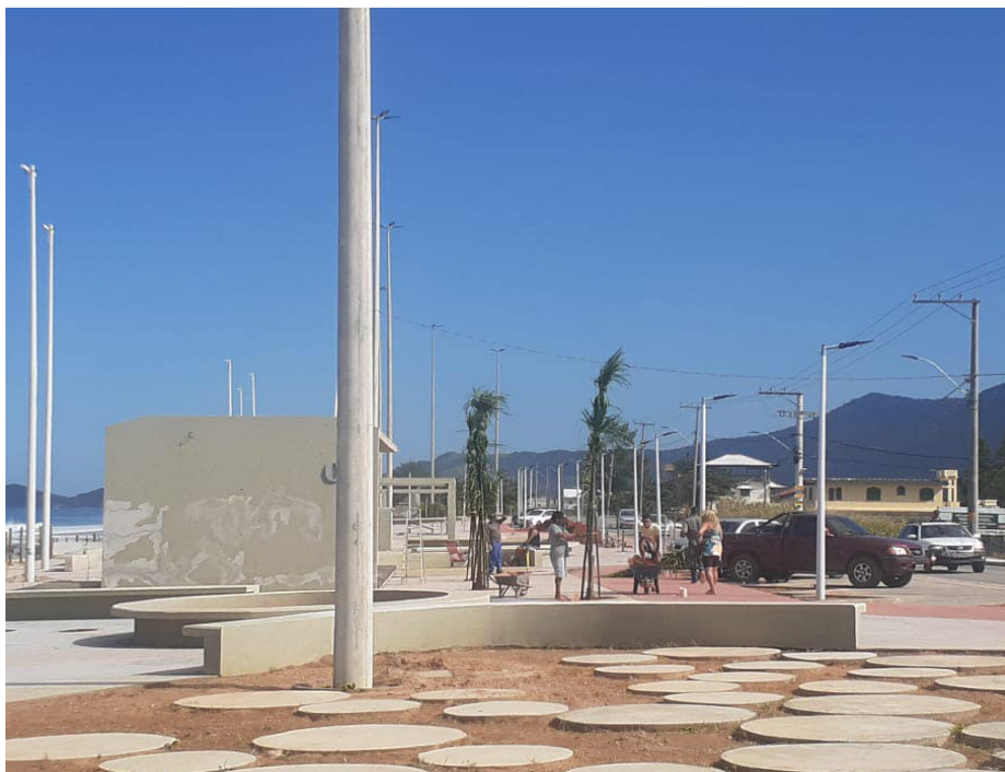
Obras da Nova Orla da Avenida 1 foram reiniciadas no bairro de Jaconé
