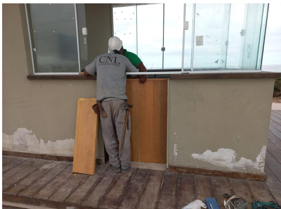
Quiosques e calçadão estão em fase de reparo e finalização das obras
