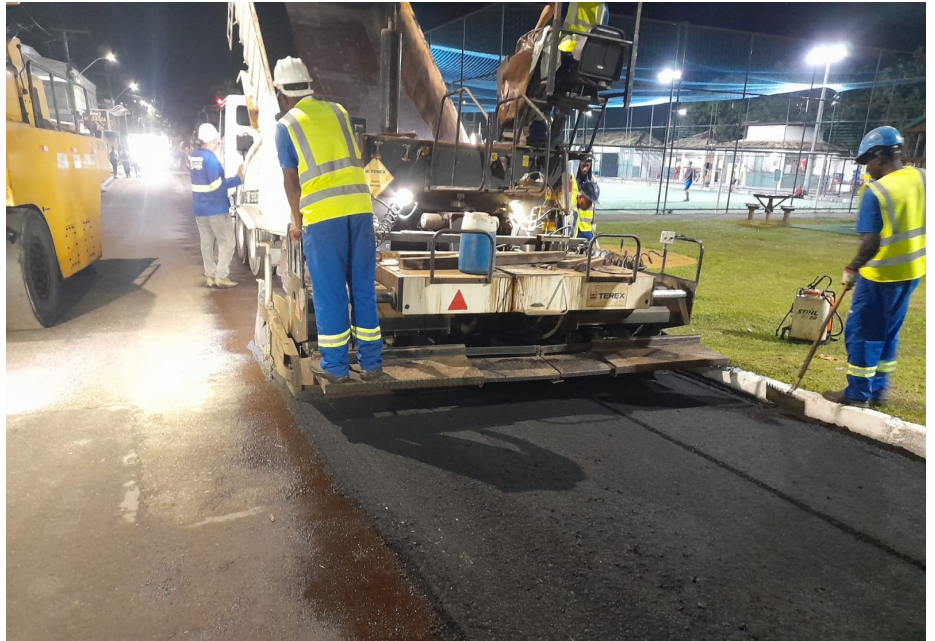
Ruas da Basiléa, em Sampaio Corrêa, recebem obras de pavimentação asfáltica
