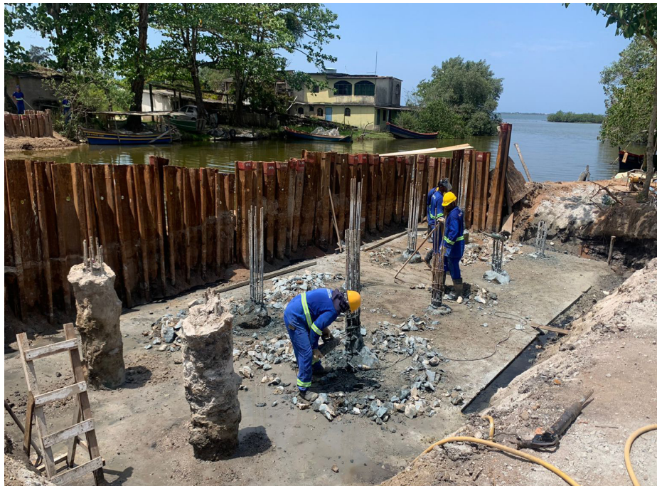
Nova ponte do Canto do Rio substituirá antiga estrutura do local
