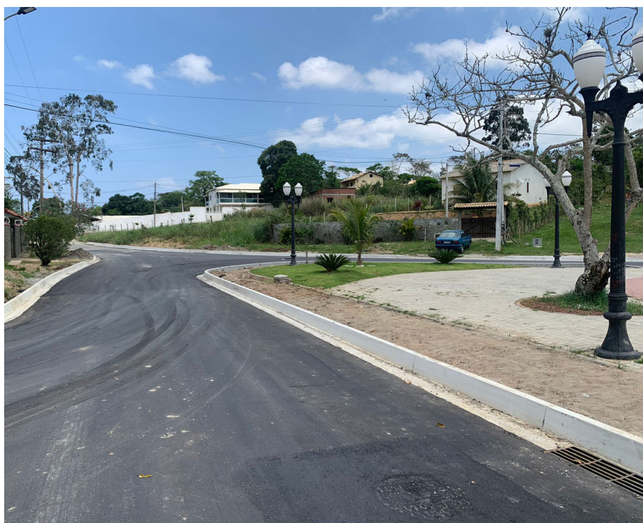
Pavimentação asfáltica já começou a ser realizada no bairro de Ipitangas
