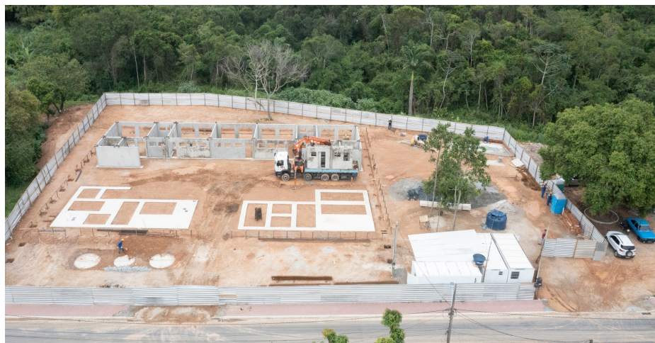
Vista aérea da construção da nova creche no bairro do Asfalto Velho
