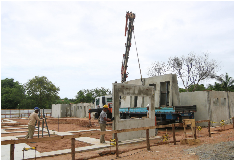
Estrutura pré-fabricada começou a ser montada no bairro do Asfalto Velho
