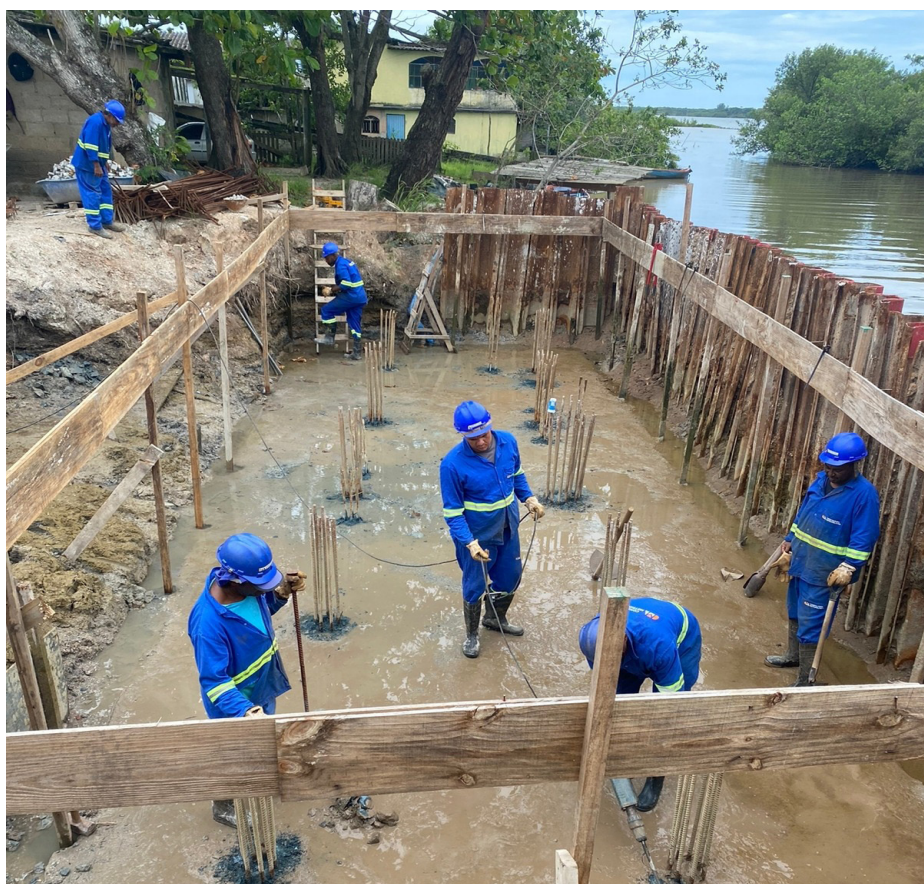
Nova ponte do Canto do Rio, em Jardim Ipitangas, está sendo construída
