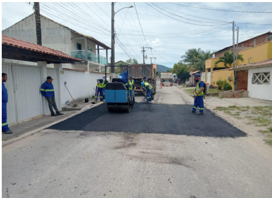
A operação Tapa Buracos acontece nas principais ruas e estradas da cidade
