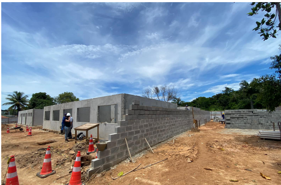
Nova creche do bairro Asfalto Velho está sendo construída pela Prefeitura
