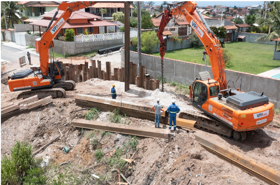
Drenagem do bairro Coqueiral está sendo um desafio para equipes de engenharia
