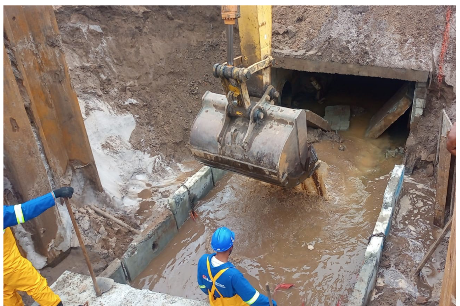
Em uma segunda etapa, a Rua dos Funcionários receberá as obras de drenagem
