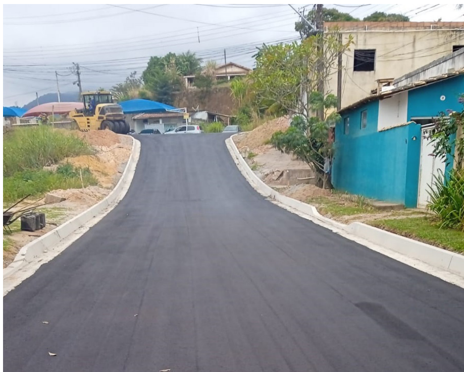
Quase 6 quilômetros de ruas estão sendo pavimentados no bairro Alvorada
