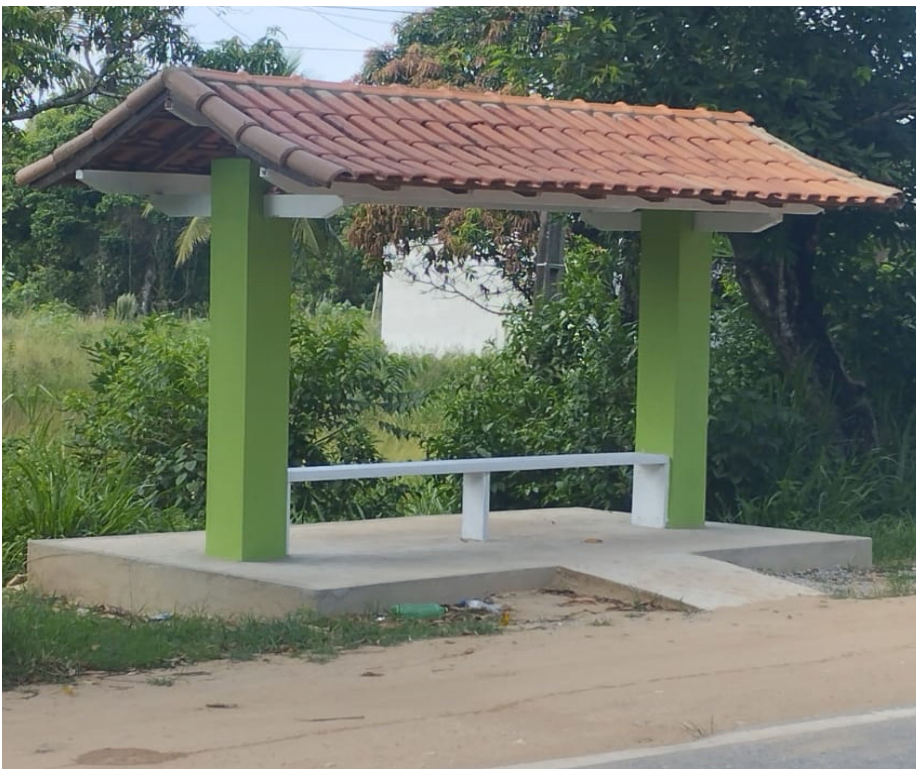
Novos pontos de ônibus, em alvenaria, possuem rampas de acessibilidade
