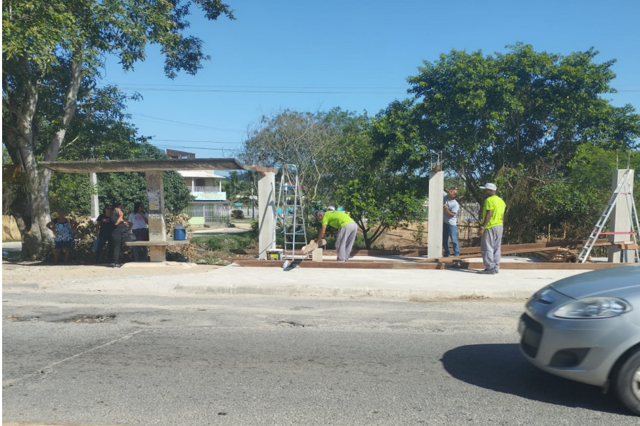
Ao todo, dezoito unidades estão em construção neste momento, na cidade
