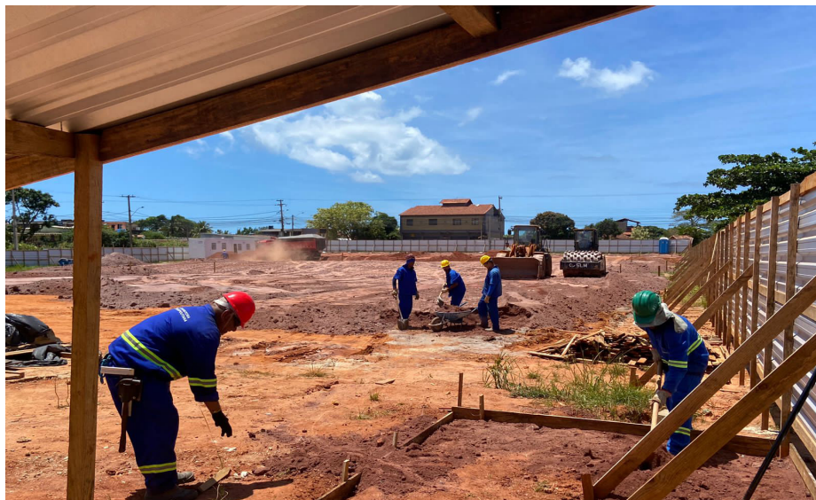
Bairros de Jaconé e Bonsucesso tiveram as obras dos complexos iniciadas
