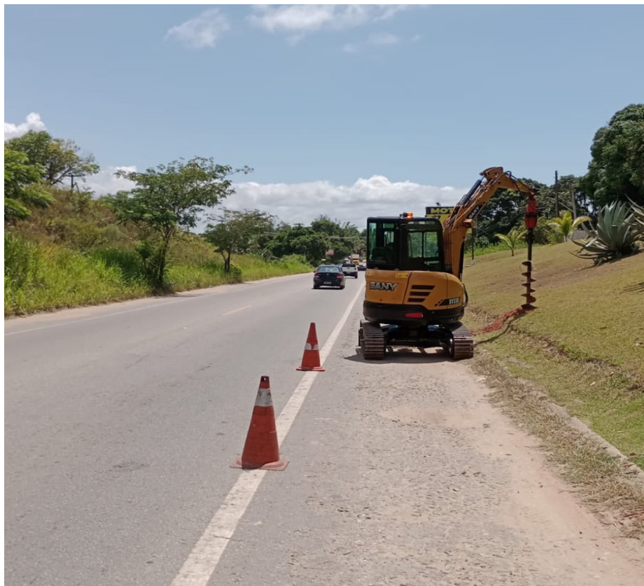
Máquinas começaram a preparar as bases para os novos postes metálicos
