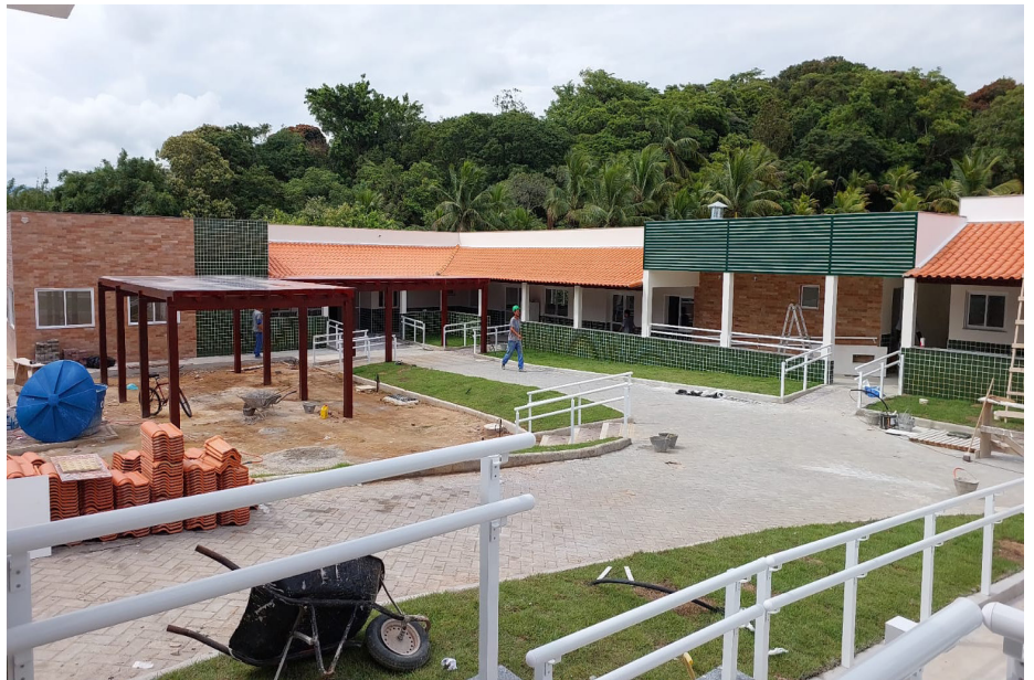
Obra de reforma e ampliação do Lar dos Idosos está em fase final no Porto da Roça
