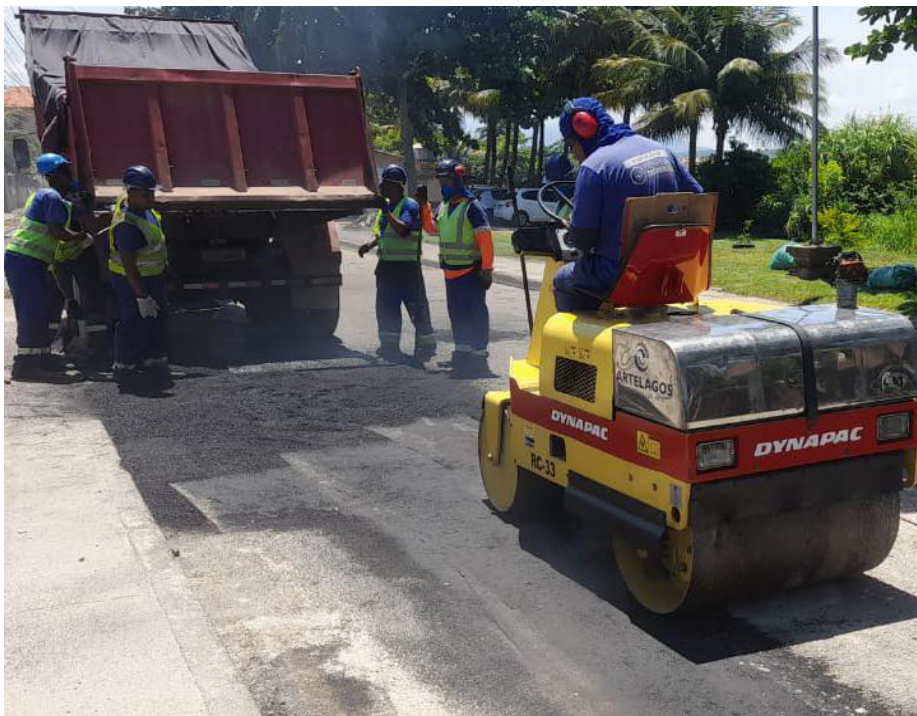
Serviços da Operação Tapa Buracos acontecem nas principais vias da cidade
