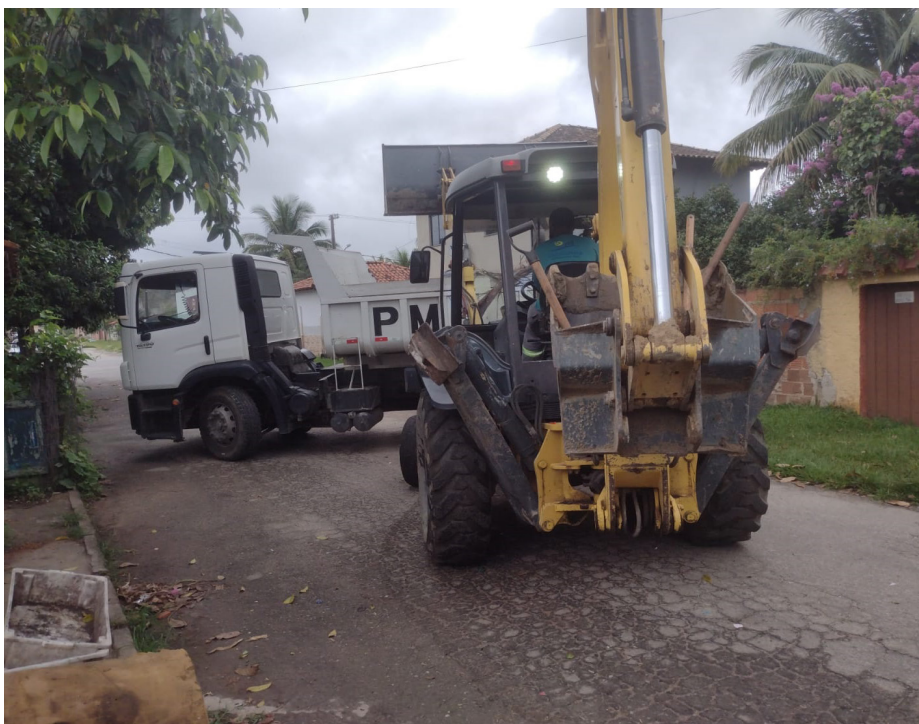
Equipes trabalham na limpeza e retirada de entulhos de diversas ruas da cidade
