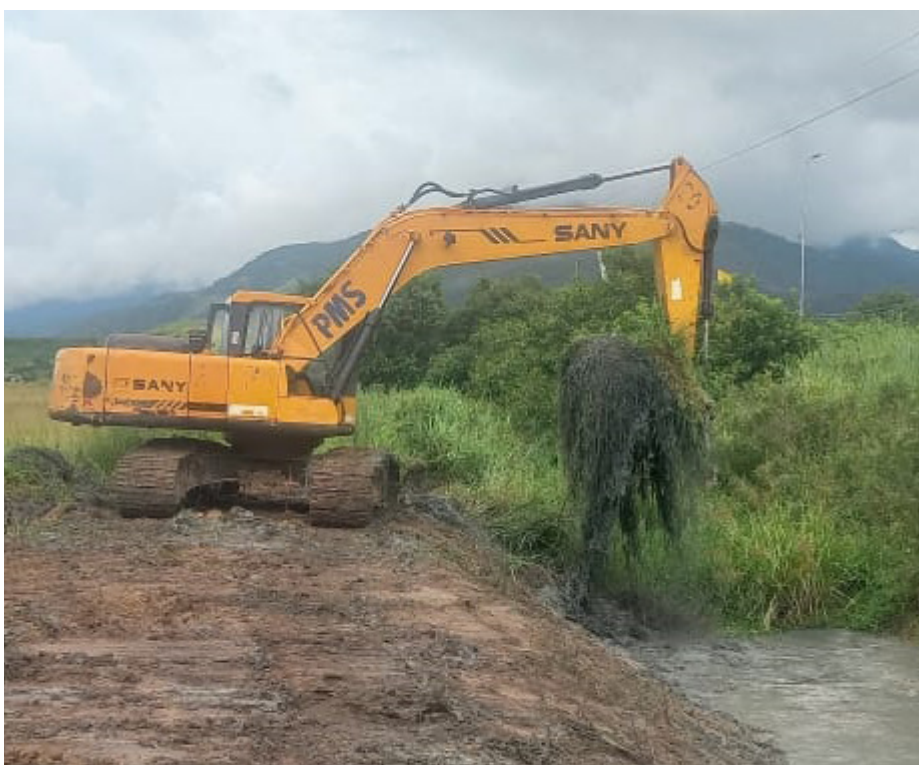
Serviço de limpeza e dragagem dos rios é executado para minimizar alagamentos
