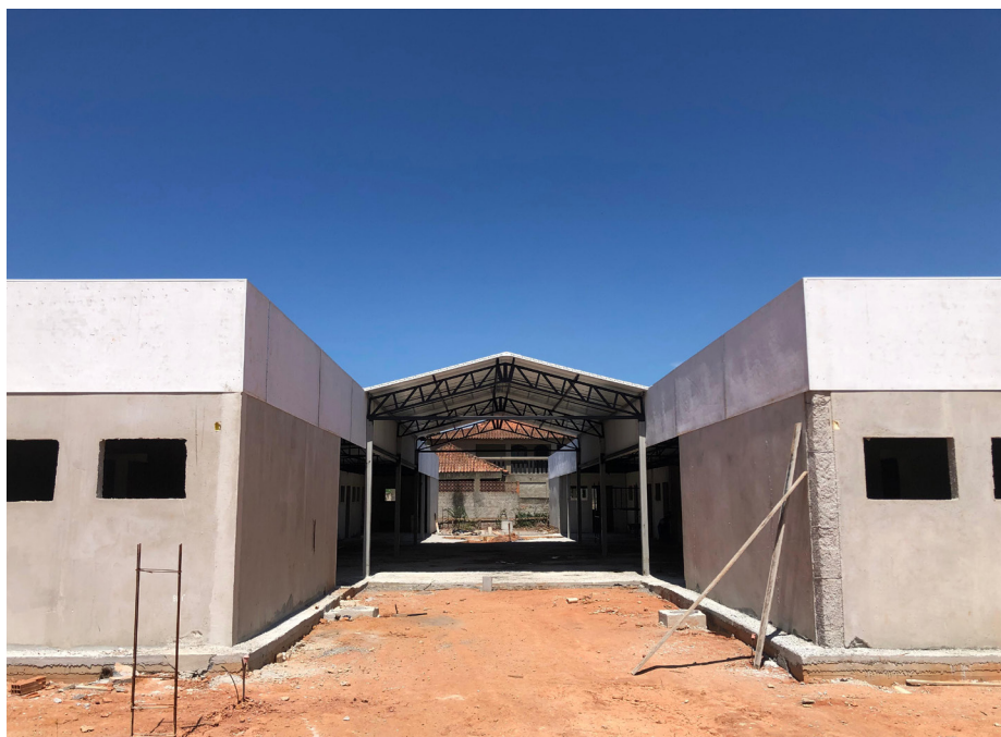
Obras da nova creche do bairro Vilatur ultrapassam os 20% de execução
